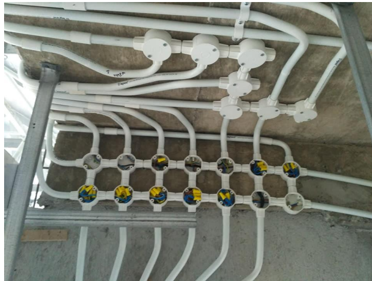
Gambar 10. Aplikasi Penekukan Pipa Listrik
